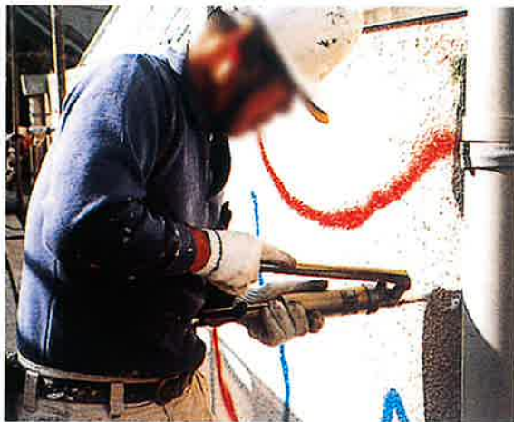
外壁モルタル等の浮き注入接着 (使用材料 BOメジコン#309)
