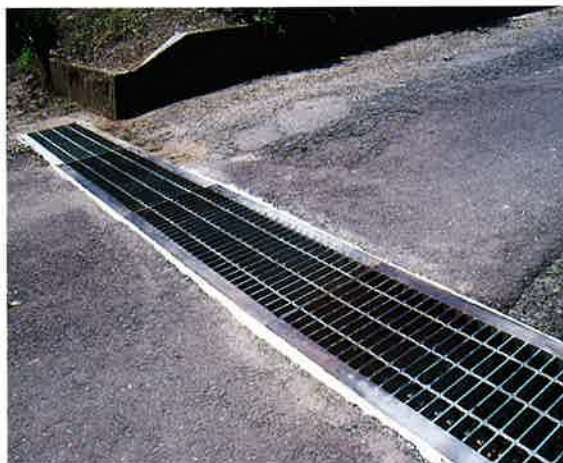
グレーチング固定 (使用材料 BOメジコン#10)
