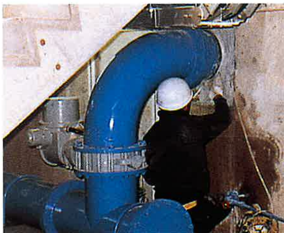
浄水場・鋼管周りシール (使用材料 BOメジコン#10)
