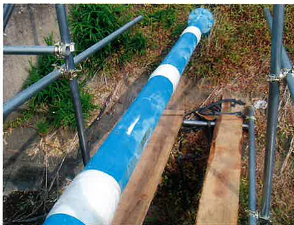
水管橋漏水補修 (使用材料 BOメジコン#10S)
