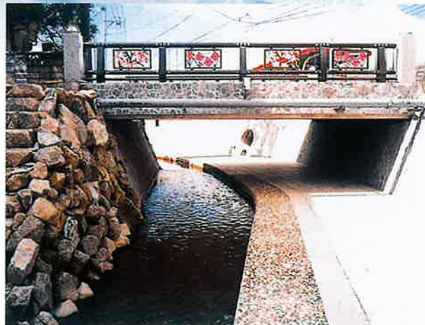
河川敷、天然石等接着 (使用材料 BOメジコン#10)
