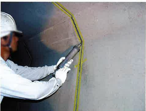
ボックスカルバートの目地充填 (使用材料 BOメジコン#10S-OZ)
