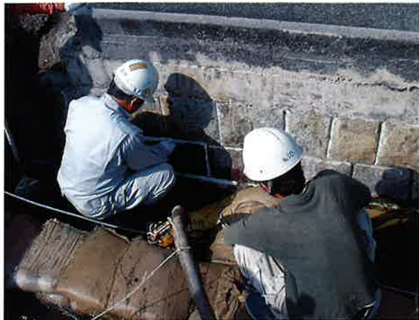
石垣の漏水補修 (使用材料 BOメジコン#10)
