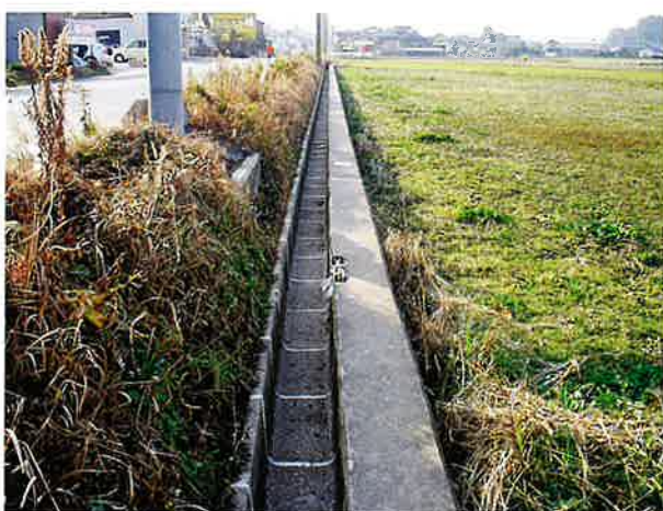
農業用水路目地補修 (使用材料 BOメジコン#10S)
