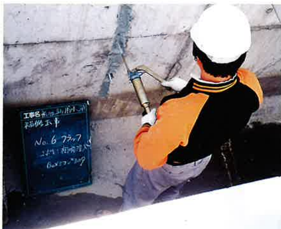
ひび割れカット注入 (使用材料 BOメジコン#309)
