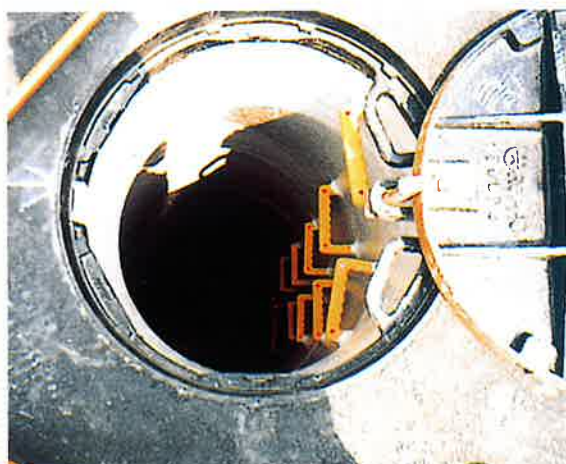
マンホールジョイントシール、ステップ接着固定 (使用材料 BOメジコン#10)
