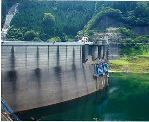
コンクリート打継 (使用材料 BOメジコン#200、#200LP)
