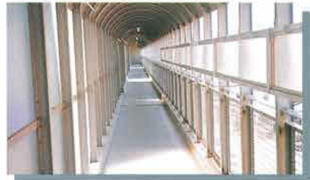
マンション廊下床
