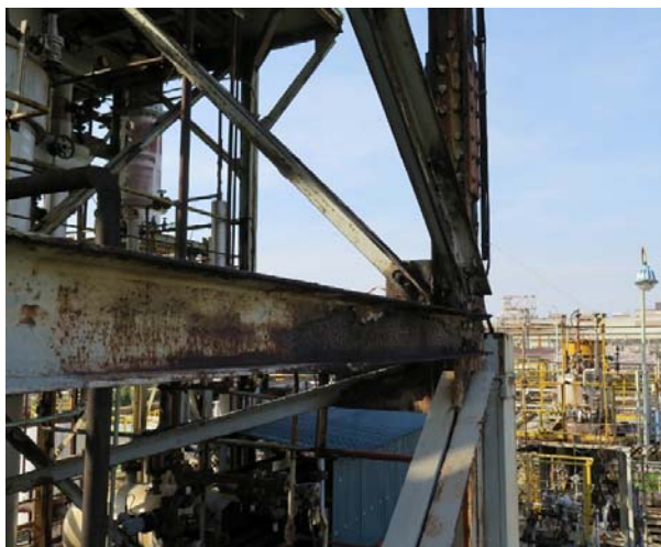
写真1 足場設置が難しく施工箇所が狭隘部
