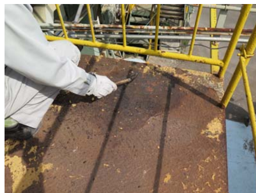
② ハンマーでの浮きさび除去
