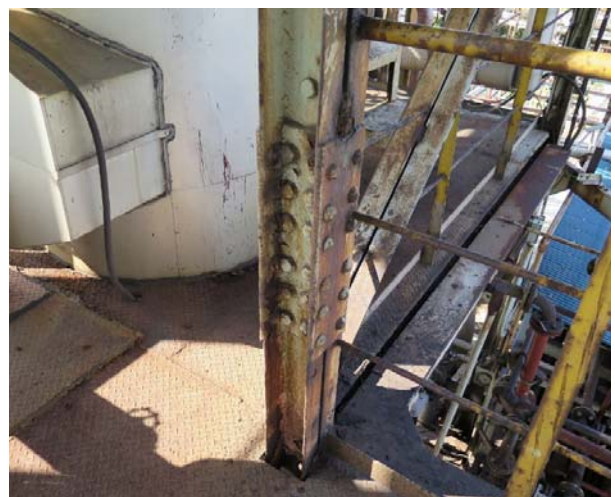
写真2 目あらしが困難なボルト周り
