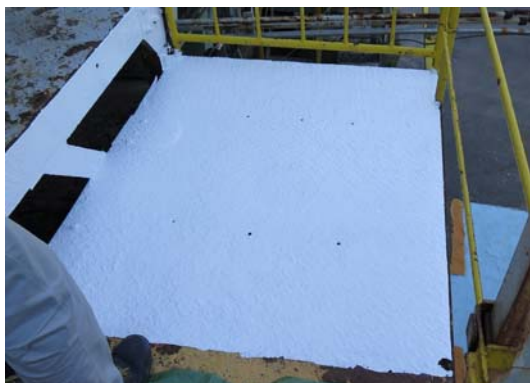
⑦ 塗装完了
