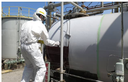
⑥3000GWT-AE 塗装後 (GWT シーラー 塗装部分)
