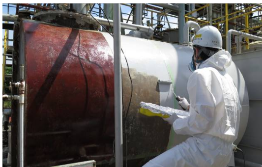
⑤3000GWT-AE 塗装 (GWT シーラー未塗装部分)
