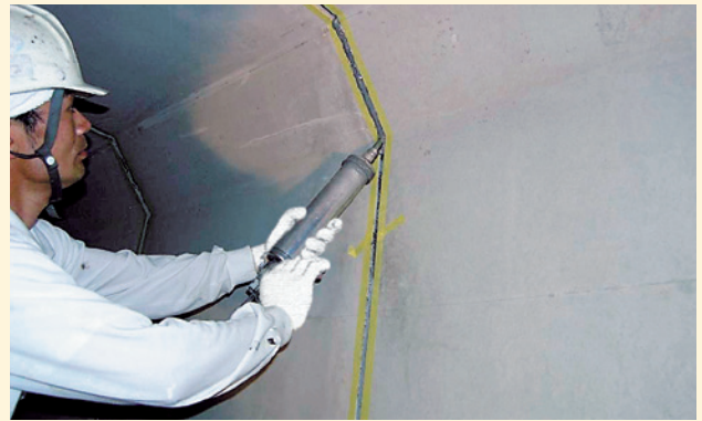
ボックスカルバートの目地充填作業 (使用材料 BOメジコン#10S-OZ)
